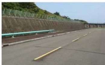
圖4：第二套熱沉連接出口管（消防水帶連接）
