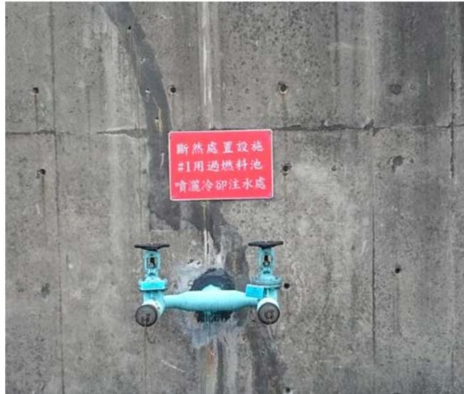
RPV補水系統經過AP-HV-203/204--配管管路
