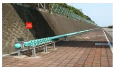
圖3：第二套熱沉連接進口管（接消防車或消防泵）
